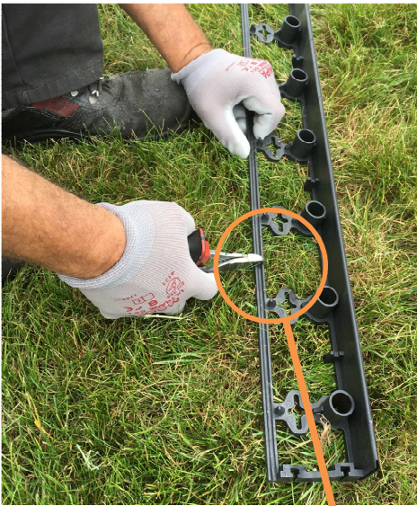
Préparation rapide d'une forme courbe en découpant les renforts à la simple pince coupante
