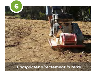
Compactez le sable à l'aide d'un compacteur ou d'une plaque vibrante
